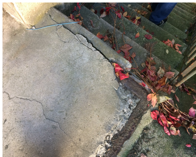
Fissures importantes de l'escalier
