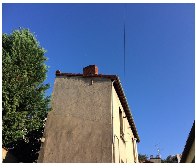
Cheminée présentant un état de péril
