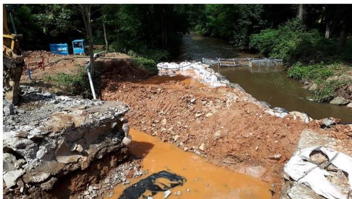
Le pompage des fonds de fouille pour maintenir la zone de travail à sec sera réalisé. La capacité de pompage prévue est de 200 m<sup>3</sup>/h, mais pourra être adaptée en fonction des besoins, notamment en fonction de la production de la nappe.
