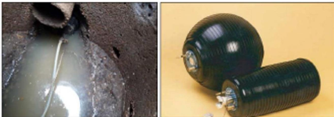
*Mise en place d'une boudruche pneumatique dans un regard d'eaux usées*
