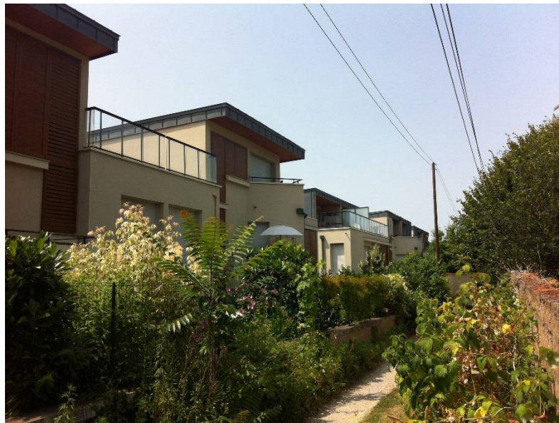
Logements intermédiaires – Croix Rousse, Lyon
