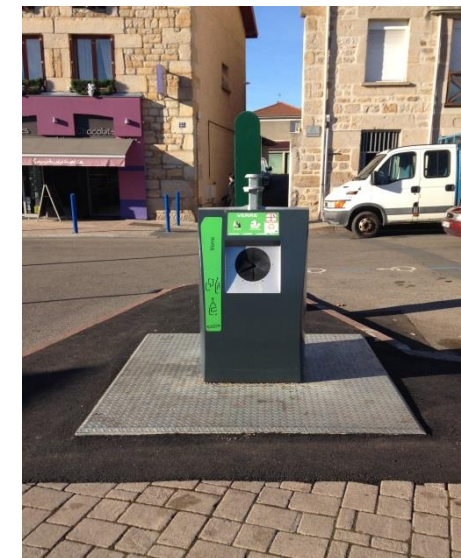
Renouvellement du conteneur enterré Place Gambetta La Talaudière
