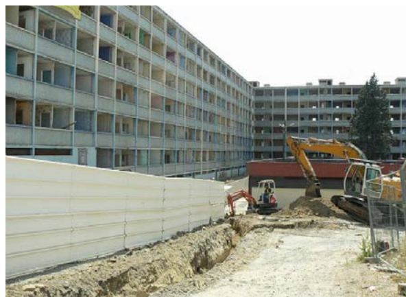
Démolition de logements sociaux à Rive-de-Gier dans le quartier du Grand Pont
