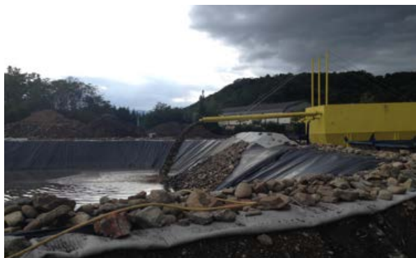
Travaux de dépollution réalisés in situ sur le site Adèle Bourdon à Lorette
