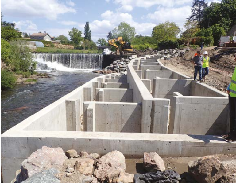
Fin des travaux d'aménagements du seuil des Peupliers à Andrézieux-Bouthéon avec réalisation d'une passe à poissons
