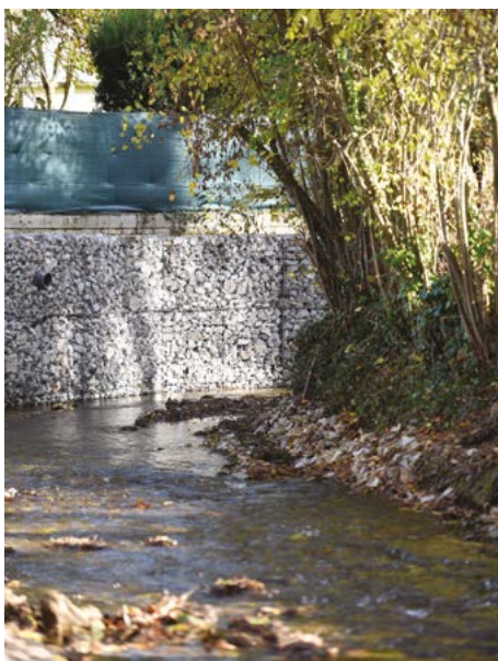
Aménagement des berges de l'Onzon à Sorbiers
