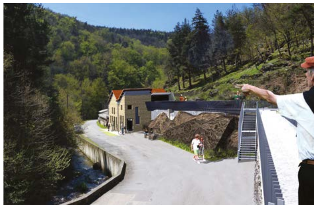
Projet d'ECM au Chambon-Feugerolles, passerelle reliant l'ancienne forge et la plateforme surplombant la retenue d'eau
